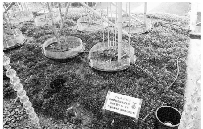
2階テラス上の竹林の植栽基盤
